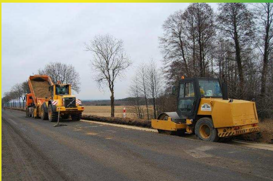
Rozbudowa drogi nr 470
